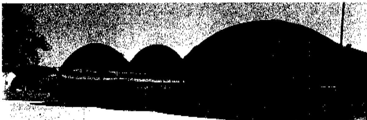
Abrigo de animais em estrutura metálica e cobertura em lona
