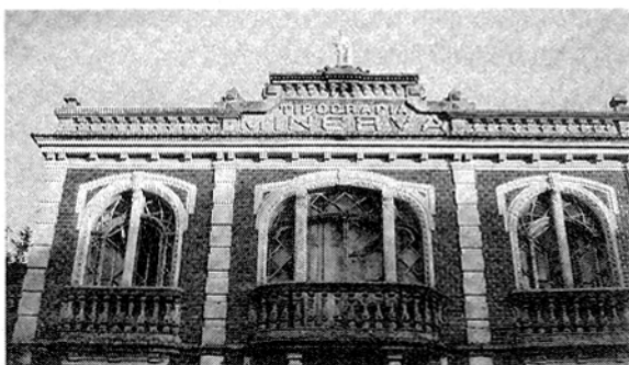
▲ Fachada actual do edifício da Tipografia Minerva
