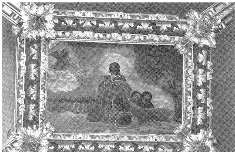
◀ 6 – Caixotão com painel
