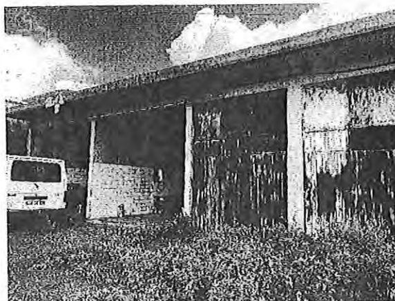
VISTA DA CONSTRUÇÃO EXISTENTE
